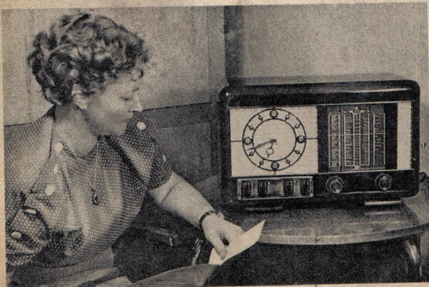
Achtkreis-Super von Lumophon mit Zeitangabe durch 8-Tage-Laufwerk
